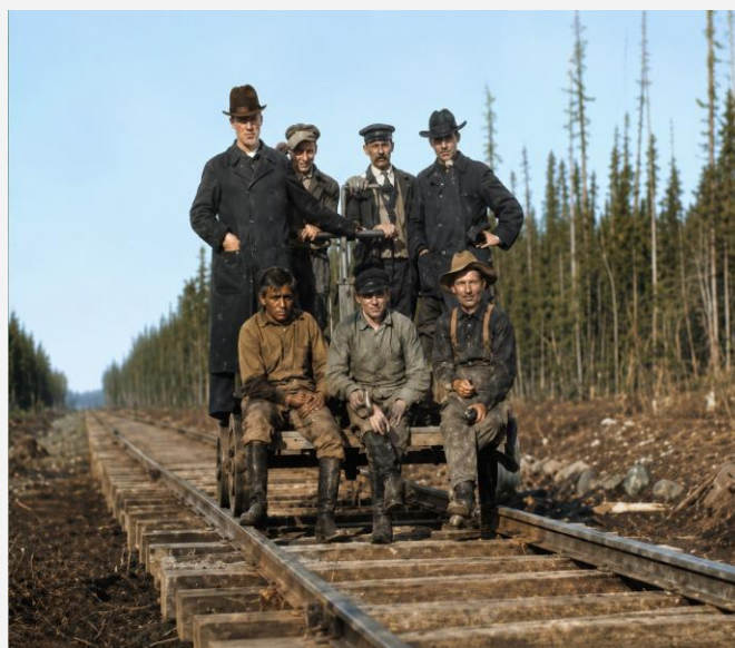
(Construction de la voie ferrée pour le Transcontinental)
